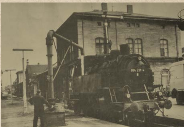
DER WASSERTURM MIT KRAN DIENTE ZUR VERSORGUNG DER DAMPKOMOTIVEN MIT GROßEN WASSERMENGEN FÜR DIE DAMPFERZEUGUNG, EIN ABGEDECKTES ÜBERBLEIBSEL DES WASSERTURMS IST BIS HEUTE ERHALTEN.
