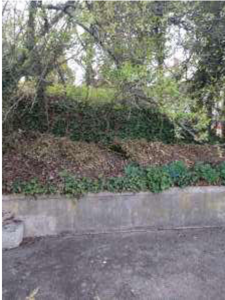
Abb4 Das Dach der Garage
